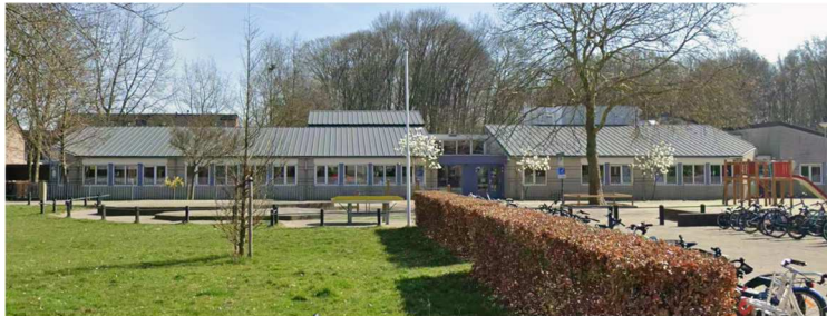
Figuur 13 Schoolgebouw Het Zuiderpad
